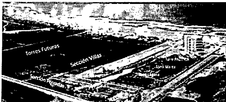
Ilustración 28. En el extremo derecho colindando con la bahía, destaca la edificación de mayor escala del área de estudio.
