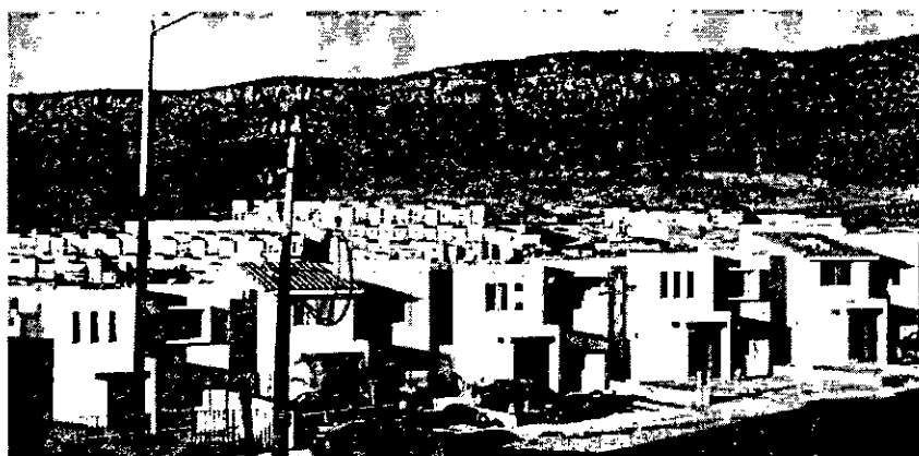
Ilustración 29. Vivienda establecida en la zona Este del área de estudio. Fraccionamiento Puerta del Mar y Juan Diego Residencial. FUENTE: Elaboración propia.
